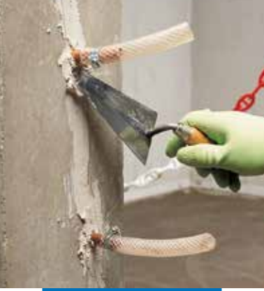
Yapısal güçlendirme için enjeksiyon tüplerinin tespiti ve çatlakların tesciti
