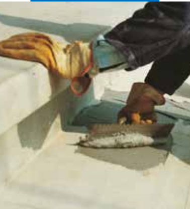
Prekast basamakların yapısal yapıştırması için Adesilex PG1'in taraklı mala ile uygulanması
