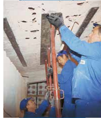
Metal plakanın yapısal güçlendirme için yerleştirilmesi
