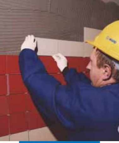
Yukarıdan aşağı doğru çalışarak duvara seramik karo uygulanması
