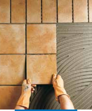
Dış mekanda klinker karo uygulaması
