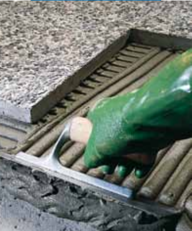
Dış mekanda terazzo "graniglia" kumtaşı karo uygulaması
