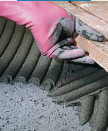
Düz olmayan bir alt yüzeyde el yapımı terakota uygulaması
