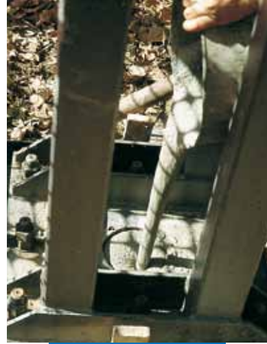
Yapısal çelik işinde Mapesfill E ile ankraj yapılması
