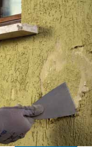
Yapışmamış tüm plastik kaplamanın uzaklaştırılması
