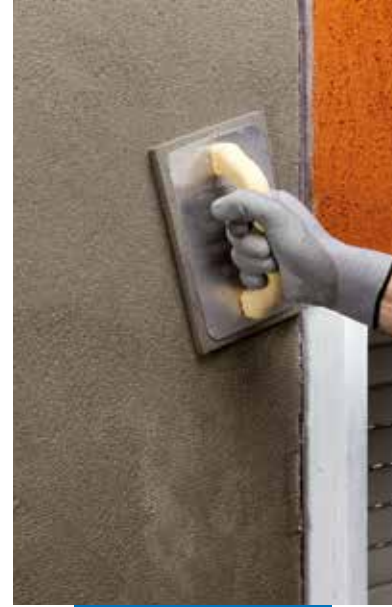
Planitop 217 yüzeyinin bitirilmesi
