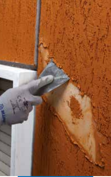
Yapışmamış tüm plastik kaplamanın uzaklaştırılması
