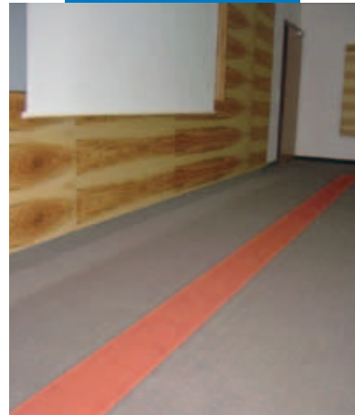
Bir otel odasında Ultraplan Eco ve halıları yapıştırmak için kullanılan Rollcoll yapıştırıcı kullanılmadan önce Primer G uygulaması örneği - Villa Hotel Castellani - Avusturya
