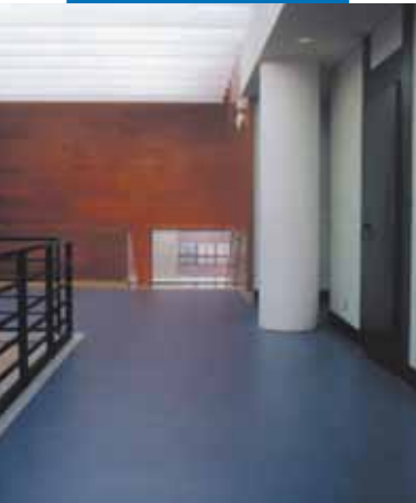
Ultraplan ile tesviye edilmiş yüzeye linolyum uygulaması örneği - Monzòn Conservatory - İspanya
