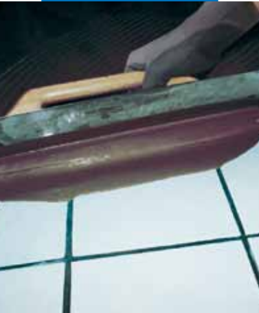
Mevcut seramik karo zemin üzerine Mapeprim SP uygulanmasından sonra metal mala ile Ultraplan uygulanması
