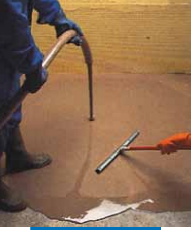
Pompa ve çekpas ile Ultraplan uygulanması
