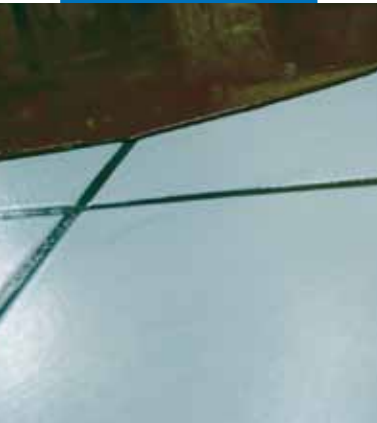
Mevcut seramik karo zemin üzerine Mapeprim SP uygulanmasından sonra Ultraplan uygulaması detayı
