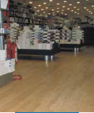
Ultraplan ile tesviye edilmiş bir yüzeye ahşap uygulama örneği - Messagerie Musicali - Roma - İtalya
